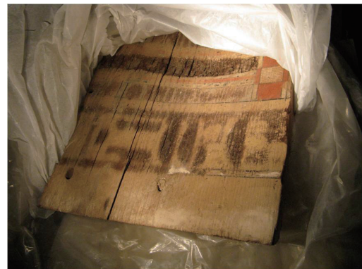
Fig.9b 劣化部分の傷み具合
